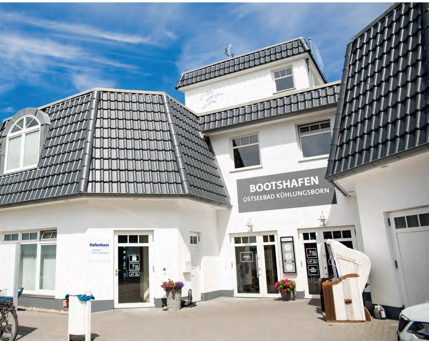
Im Jahr 2016 gab es einen neuen Anstrich für das Hafenhaus.
